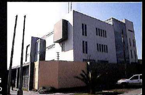
VICTORIA KIDS Arquitecto Samuel Cárdenas Gálvez
